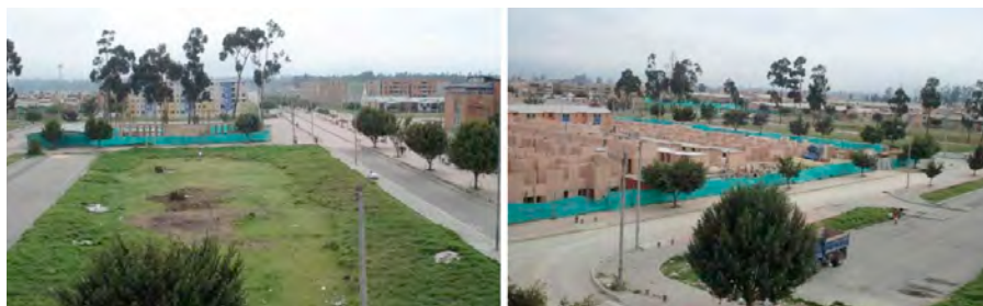
Figura 5 – À esquerda, vê-se quadra já urbanizada e ainda não ocupada e à direita em processo de urbanização
