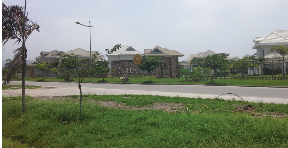
Figura 17 - Condomínio fechado Riviera Del Sol construído na Estrada do Rio Morto
