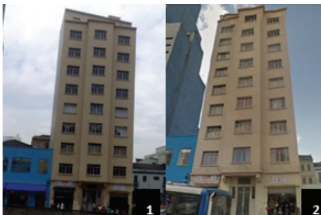
Figura 5 - Imóveis não utilizados que cumpriram as obrigações
