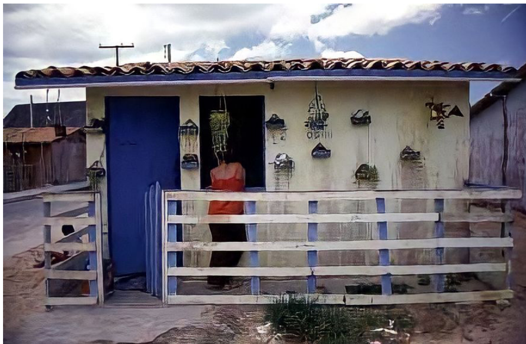
Figura 3. Casas de compensado do conjunto Joanes Centro Oeste (1982)
