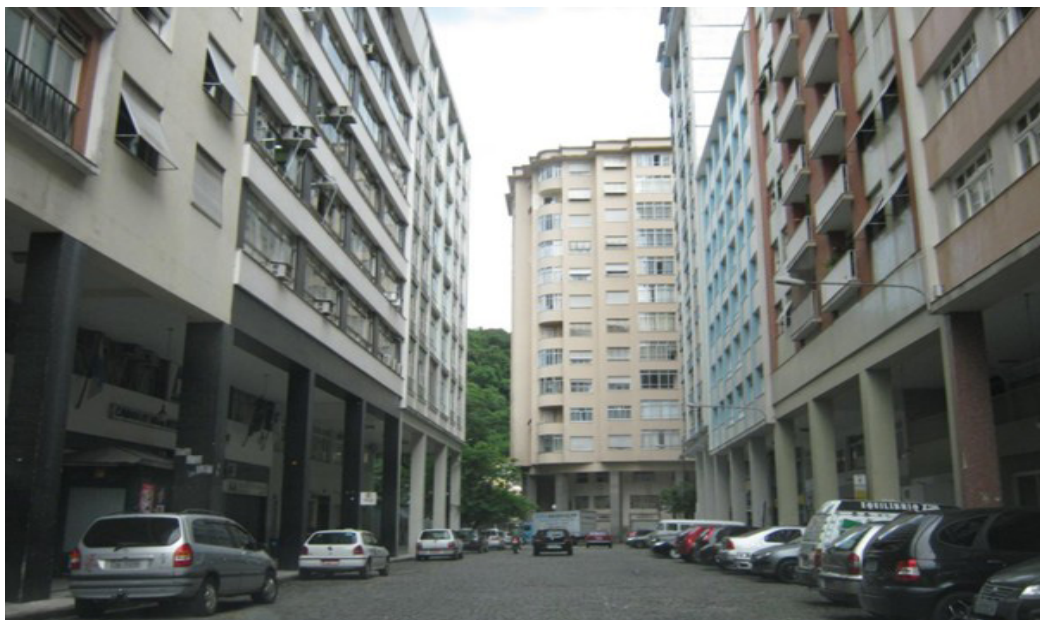
Figura 4. Rua Irmãos D'Ângelo e Edifício Arcádia (ao fundo)
