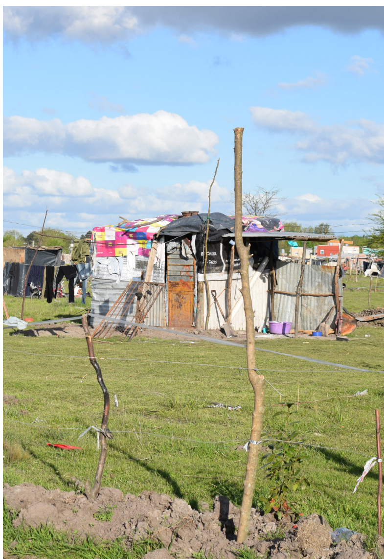
Figura 3. Vivienda precaria en la recuperación de tierras de Guernica Fuente: Fotografía de Francesca Ferlicca, 2020.
