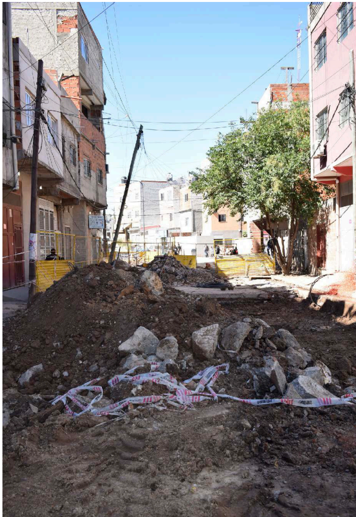
Figura 2. Abertura de la calle Miralla durante el proceso de reurbanización Fuente: Fotografía de Francesca Ferlicca, 2020.
